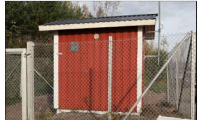
Kuva. Pumppaamorakennus Järvenpäässä, kuva Xylem.
