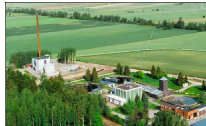
Kuva. Seinäjoen jätevedenpuhdistamo ja lämpöpumppulaitoksen työmaa.
