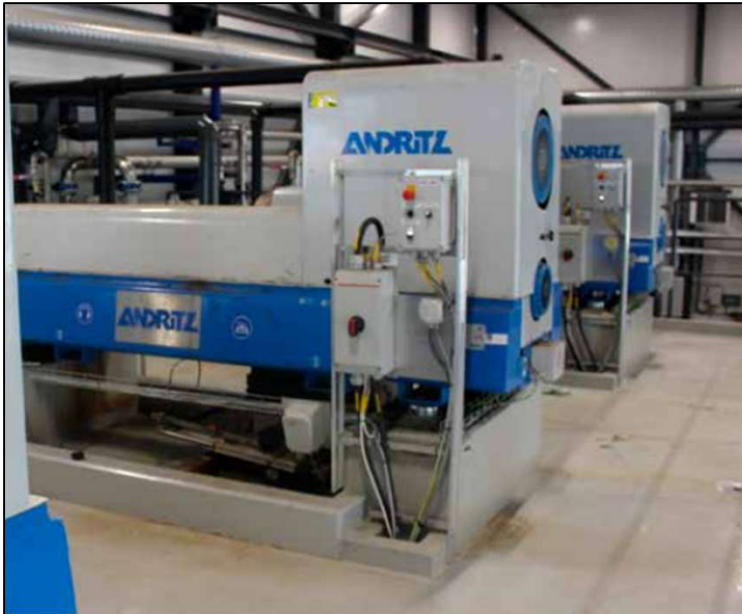
Kuva. Uuden raakalietteen käsittelyrakennuksen esitiivistyslingot Nenäinniemen puhdistamolla.
