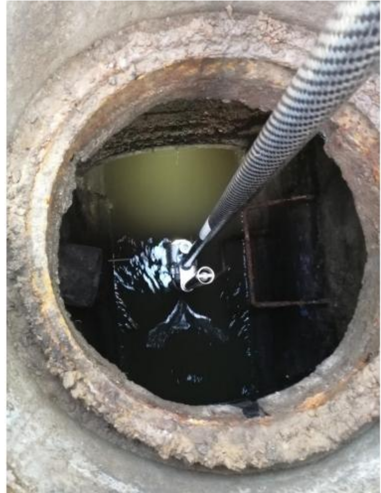
Kuva SewCon Kuikka Oy.
