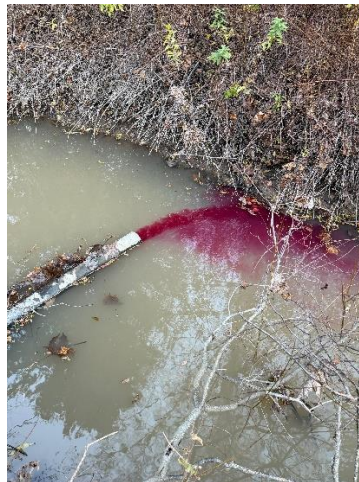
Kuva 7. Väriainekokeen avulla löytynyt tonttijätevesiviemäri, joka purki avo-ojaan. (Kuva Sujutek Oy)
