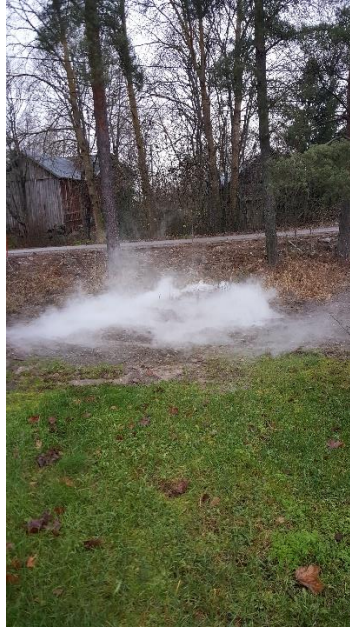
Kuva 6. Savukokeen avulla löytyi tonttijätevesiviemäri, jota ei tiedetty olevan. (Kuva Sujutek Oy)
