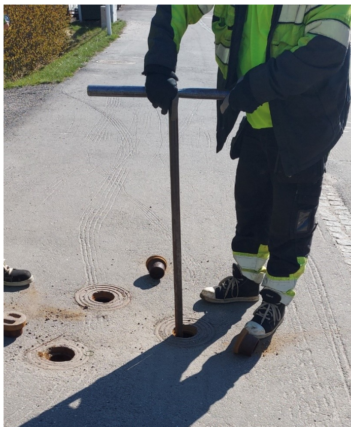
Kuva 7. Sulkuventtiilin pyöriteltävyyden tarkastaminen.
