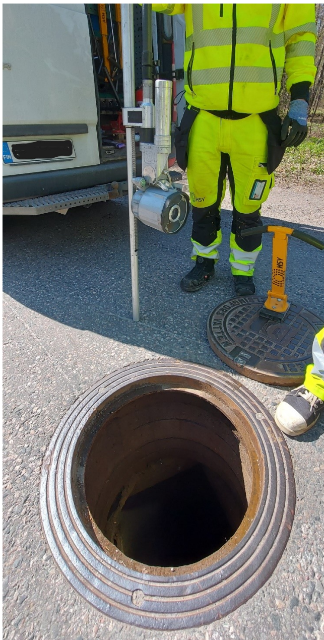
Kuva 8. Viemärikuvaukseen käytettävä zoom-kamera.
