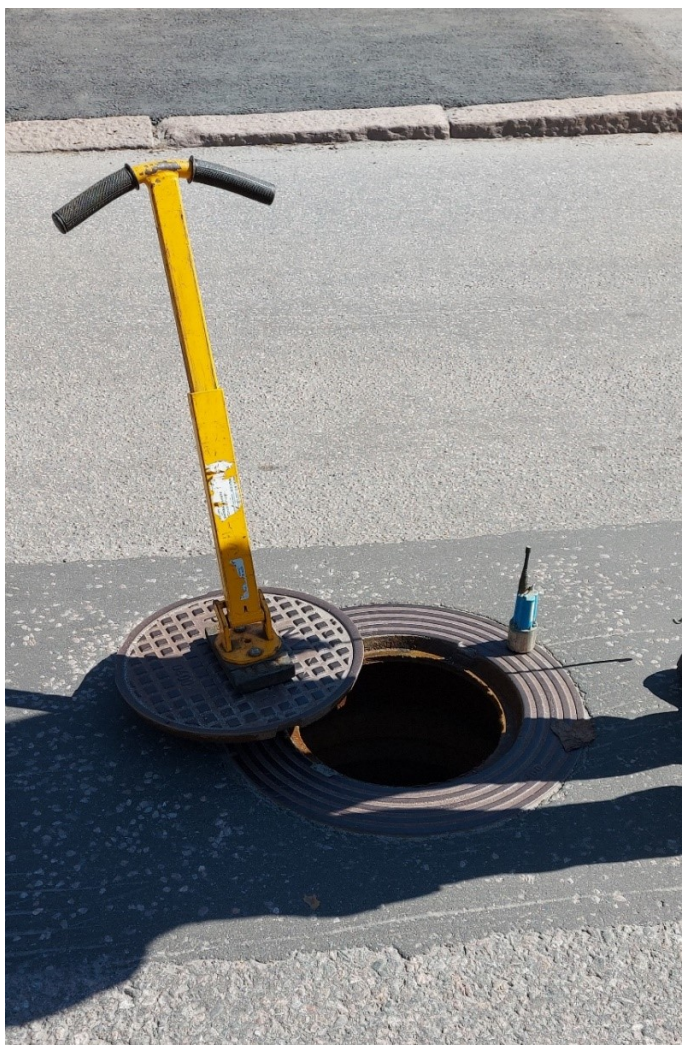
Kuva 9. Metalliputkien kuunteluun käytettävä ääniloggeri.
