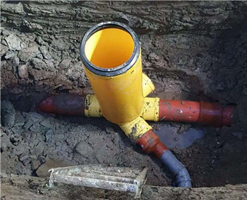
Kuva 2. Viemärikaivoon liittyvät putket näkyvät, kun kaivanto on auki. Kuva: Sujutek Oy.
