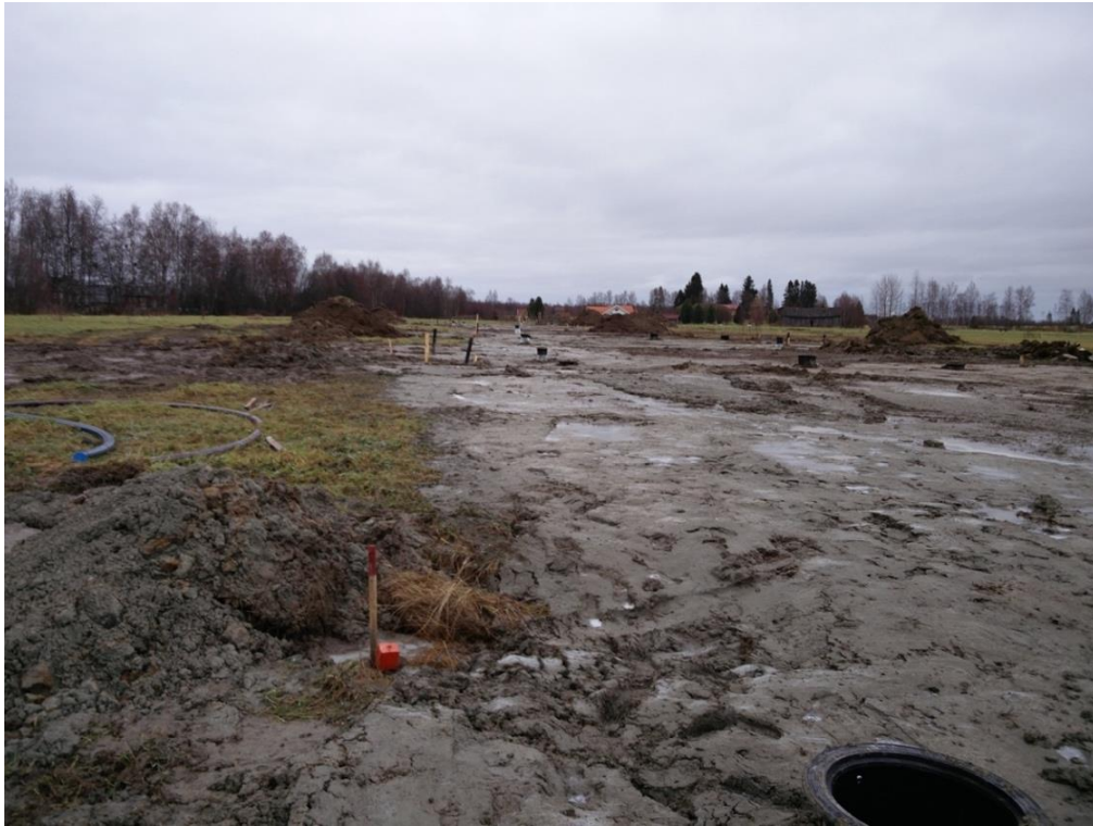
Kuva 7. Valmiit vesihuoltojärjestelmät Kirkonrannan työmaalla.
