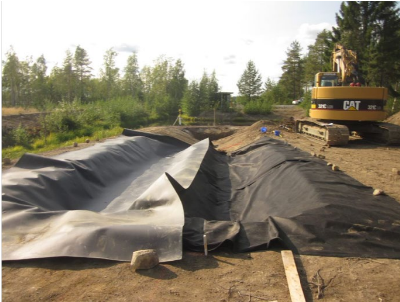
Kuva 12. Bioreaktorikaivannot. Kuva: Heini Postila.
