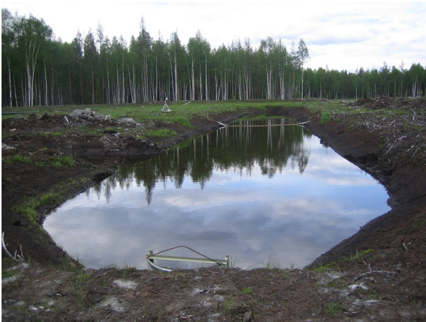
Kuva 1. Äijönnevan turvetuotantoalueen pintapuomillinen laskeutusallas. Kuva: Heini Postila.
