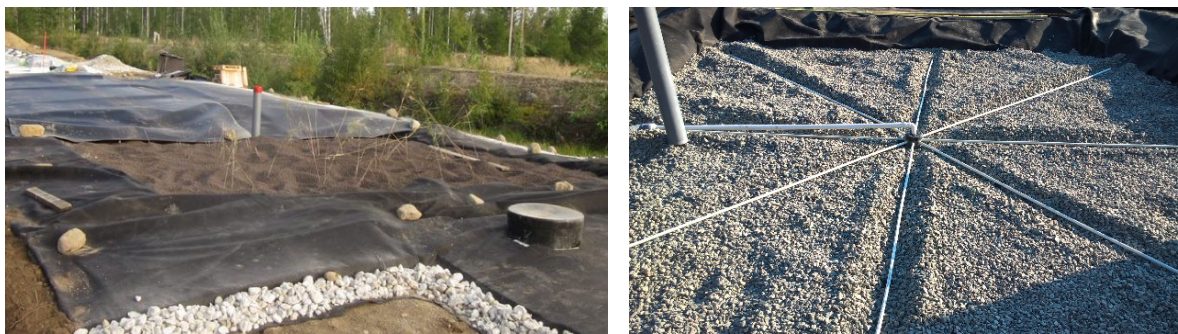
Kuva 13. Vasemmassa osakuvassa kosteikko osana pilottirakennetta ja oikeassa kosteikon kastelu-järjestelmä ennen kuin se peitetään soralla ja Leca®-soralla. Kuvat: Heini Postila ja Tuomo Pitkänen.
