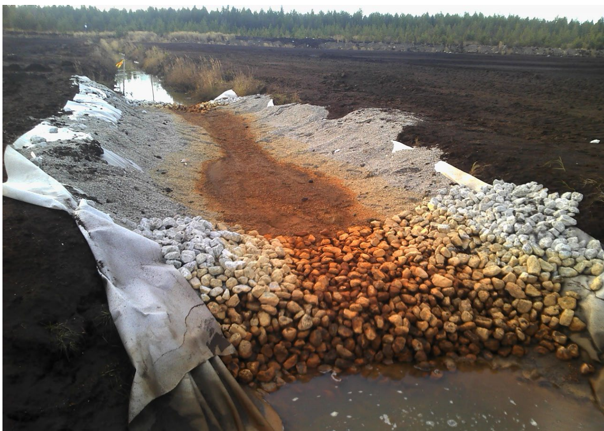
Kuva 5. Kalkkisuodinpato. Kuva: Heini Postila.
