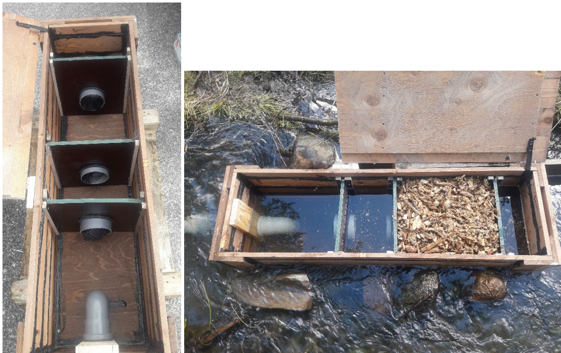
Kuva 48. Vasemmanpuoleisissa kuvassa laatikkorakenne tyhjänä ja oikeanpuolimmaisessa kuvassa laatikkorakenne ojaan asennettuna. Kuvat: Tuomo Reinikka.
