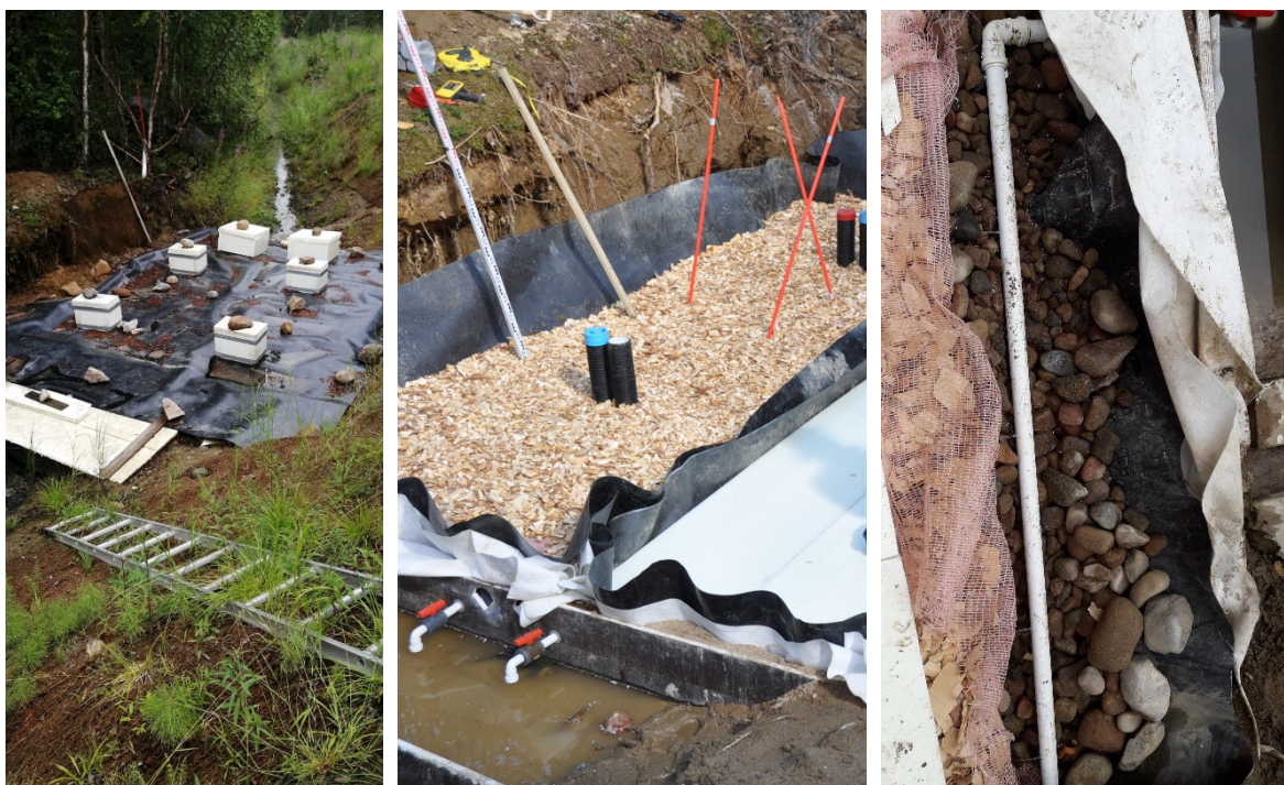
Kuva 32. Vasemmanpuoleisessa kuvassa näkyy koko bioreaktorirakenne suojattuna kesällä 2020, keskimmaisessä bioreaktori tekovaiheessa ja oikealla bioreaktorin alkupään rei'itetty vedenjakoputki. Kuvat: Piippa Wäli, Anne Korhonen ja Heini Postila.
