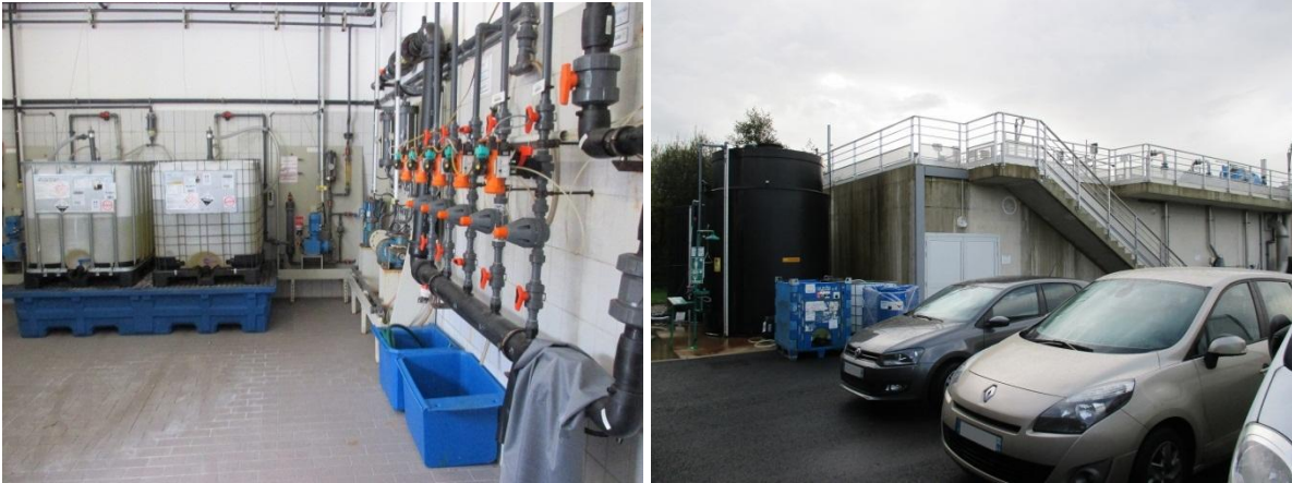
Kuva 13. Vasemmalla tyypillisiä pesukemikaalien kontteja ja oikealla musta laimennussäiliö kemikaalien kierrättämiseen.
