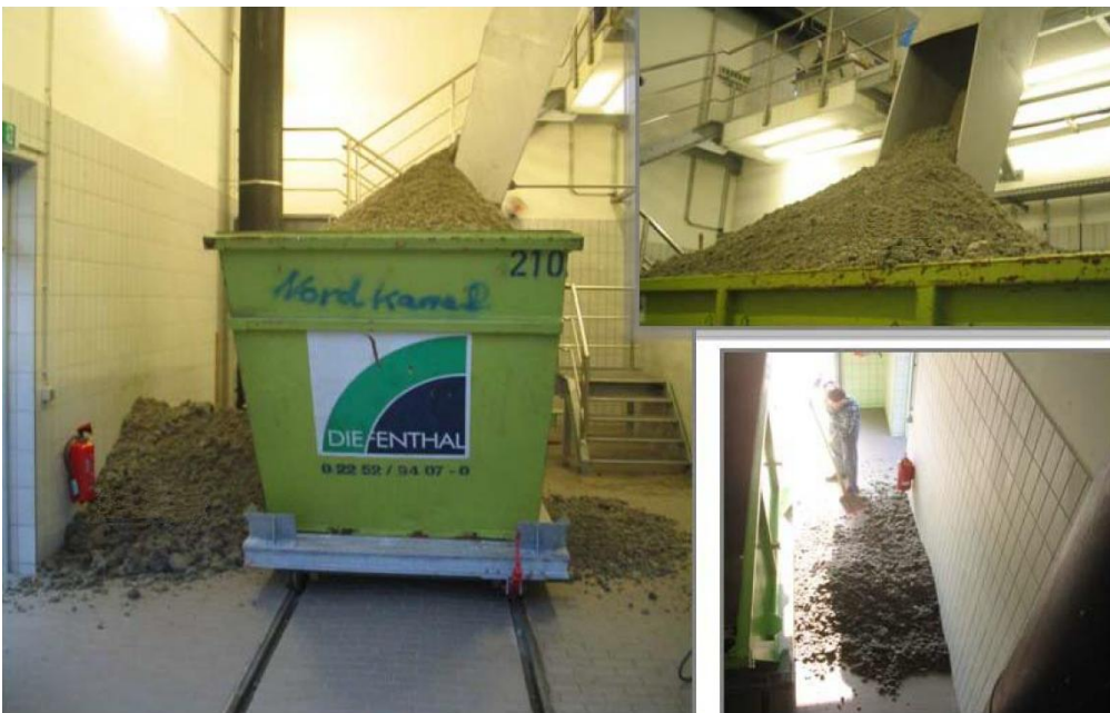
Kuva 18. Nordkanalin hienovälpettä viikonloppuna esiintyneen maksimivirtaaman jäljiltä (Frechen 2010).
