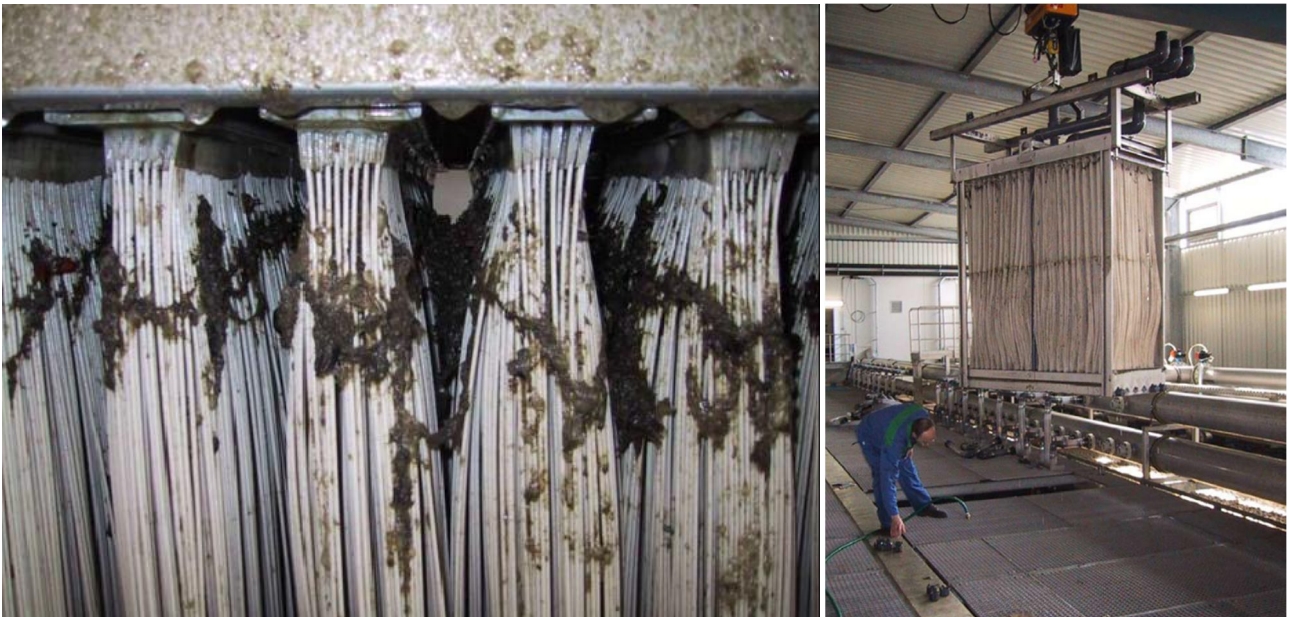
Kuva 13. Nordkanalin MBR-puhdistamolla havaittua kuitujen aiheuttamaa tukkeutumista ja kalvojen puhdistusta. (Erftverband)
