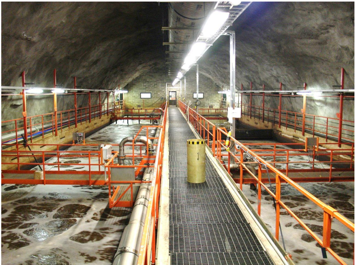
Kuva 3 Kariniemen jätevedenpuhdistamo (Lahti Aqua Oy, 2012).
