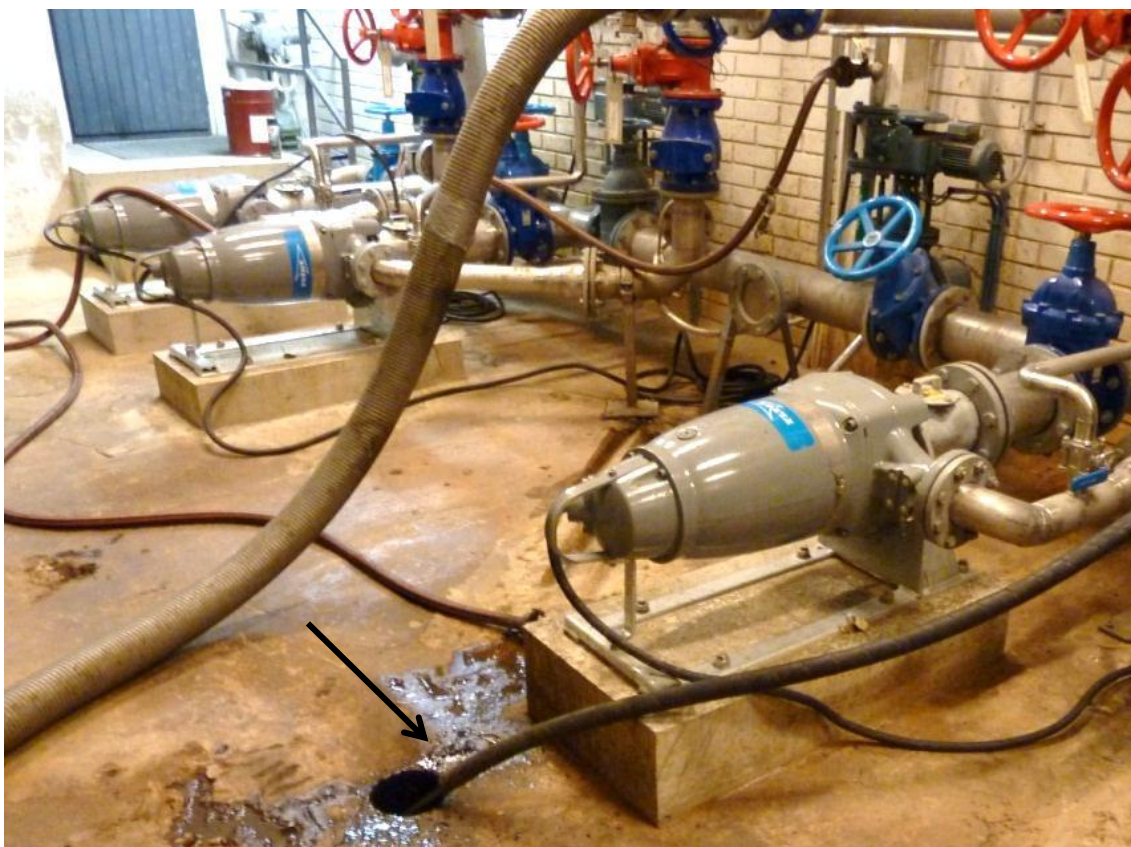
Kuva 9 Mädätetyn lietteen näytteenotto lietepumpulta Suomenojan jätevedenpuhdistamolla. Näyte otettiin oikeanpuoleisen lietepumpun näytteenottoletkusta. (Kuva Miia Arkiomaa, 2012).
