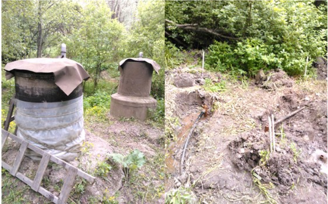
Kuva 28. Länsi-Keimolan vedenottamo oikealla ja vasemmalla keräilykaivot
