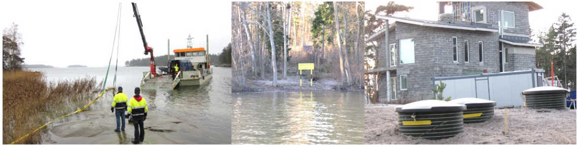
Kuva 30. Villingin vesiosuuskunnan verkosto on vastikään rakennettu.
