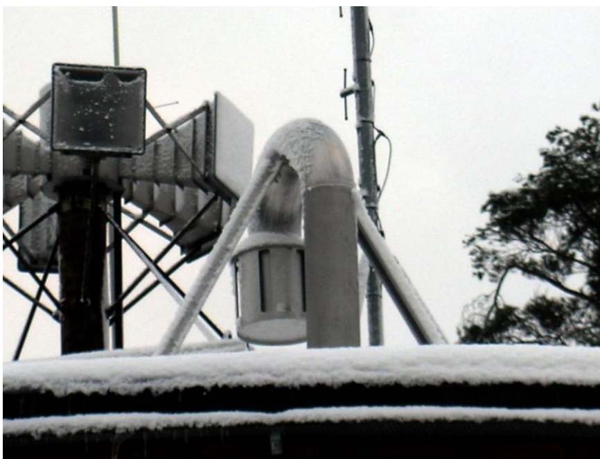
Kuva 24. Vesisäiliöiden on oltava tiiviitä ja tuloilma on suodatettava. Vesisäiliön toimiminen kuvan mukaisena laitealustana ei ole suositeltavaa.
