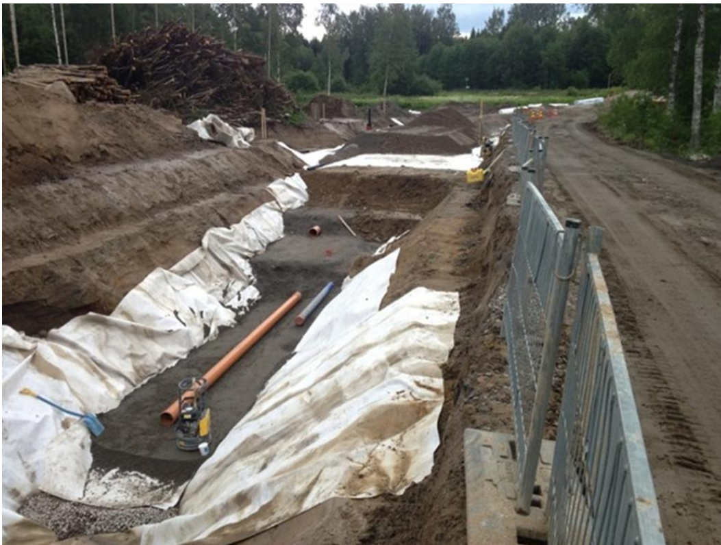
Kuva 20. Putken päät on suojattava työmaalla vesitiiviillä tulpilla.
