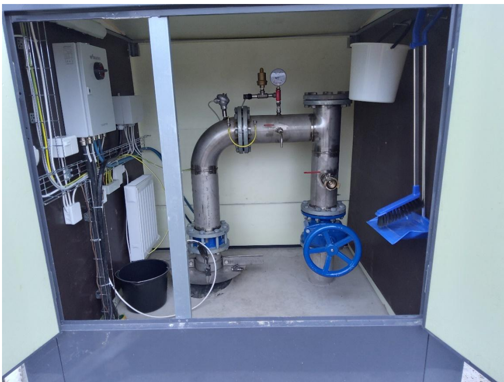
Kuva 10. Kaivokoppi. Kuva: Maanrakennus Jokinen Oy.
