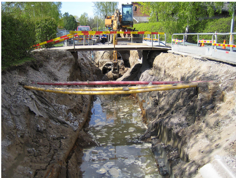
Kuva 6. Kaivannon luiskaus ja suojaus.
