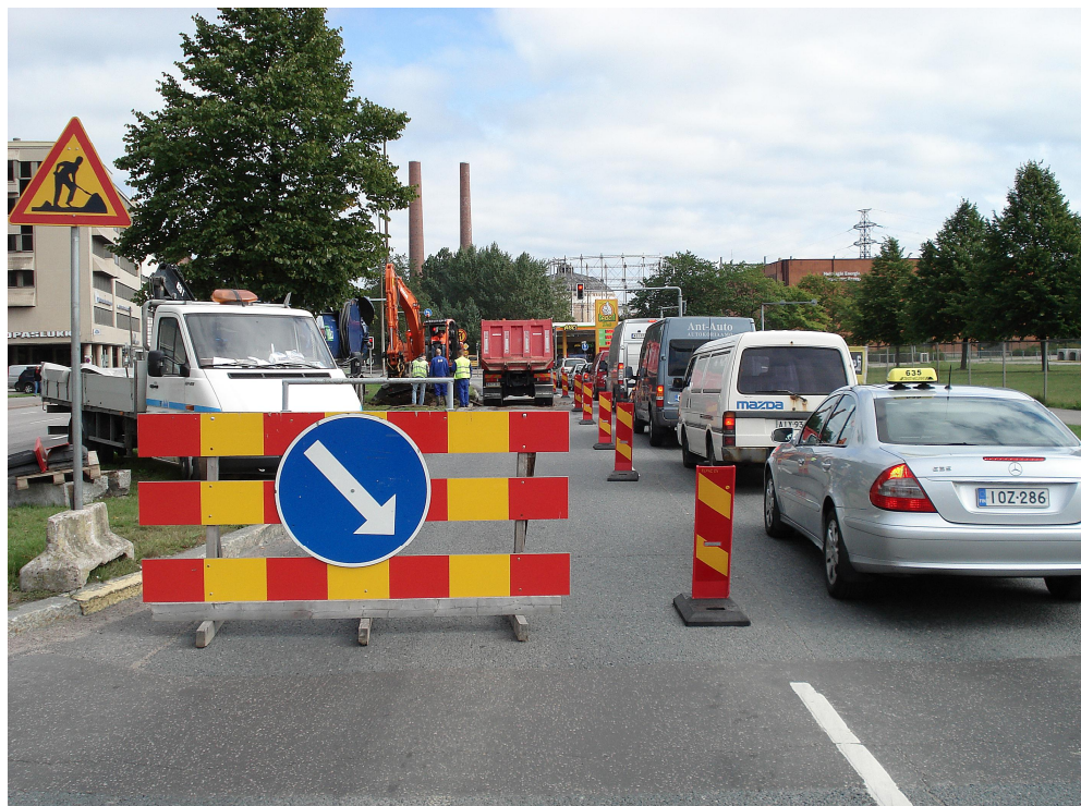
Kuva 4. Putkivauriokohteen eristäminen liikennealueella.
