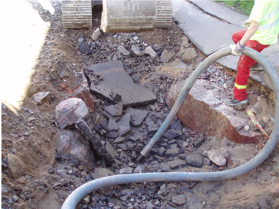
Kuva 7. Kaivannon kuivana pito.
