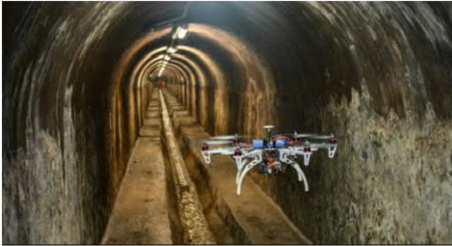
Kuva 4.4. Dronetutkimusta viemäritunneleissa. https://www.thelocal.es/20151207/could-drones-soon-replace-workers-in-barcelonas-sewers
